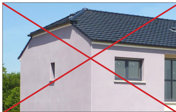
Demi croûpe de toiture interdite
