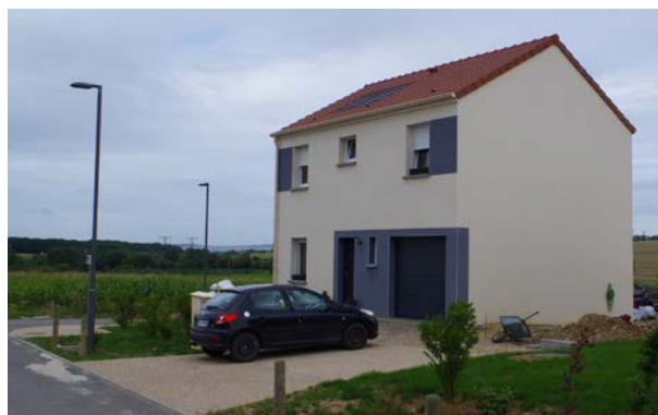
ZAC Derrière le Château à Pontoy Exemple d'entrée charretière (en béton désactivé)
