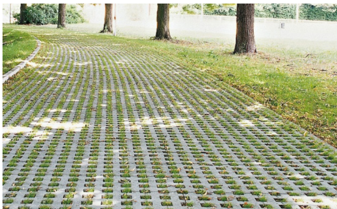
Exemples de dalles alvéolées : en béton avec engazonnement (à gauche), en plastique avec gravillons (à droite)
