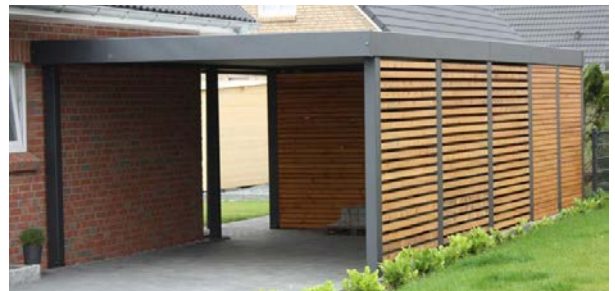
Carport à structure métal / remplissage bois
