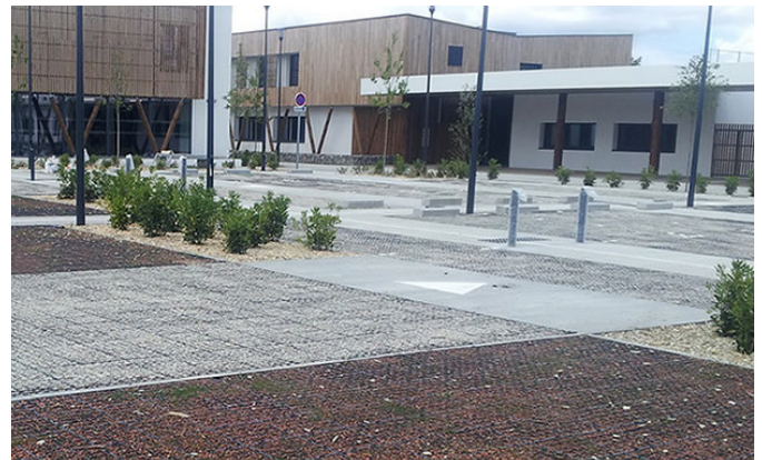
Exemples de dalles alvéolées : en béton avec engazonnement (à gauche), en plastique avec gravillons (à droite)
