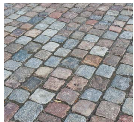
Exemples de dallages et pavages jointoyés avec des matériaux perméables (terre végétale, sable, ...)
