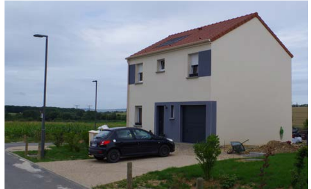
ZAC Derrière le Château à Pontoy Exemple d'entrée charretière (en béton désactivé)
