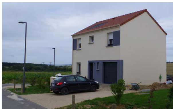
ZAC Derrière le Château à Pontoy Entrée charretière en béton désactivé
