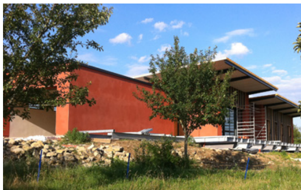
Enduit coloré - Studiolada - Puzieux
