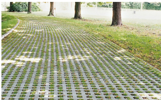
Exemples de dalles alvéolées : en béton avec engazonnement (à gauche) ou avec gravillons (à droite)
