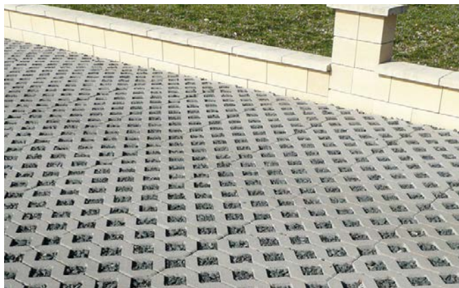
Exemples de dalles alvéolées : en béton avec engazonnement (à gauche) ou avec gravillons (à droite)
